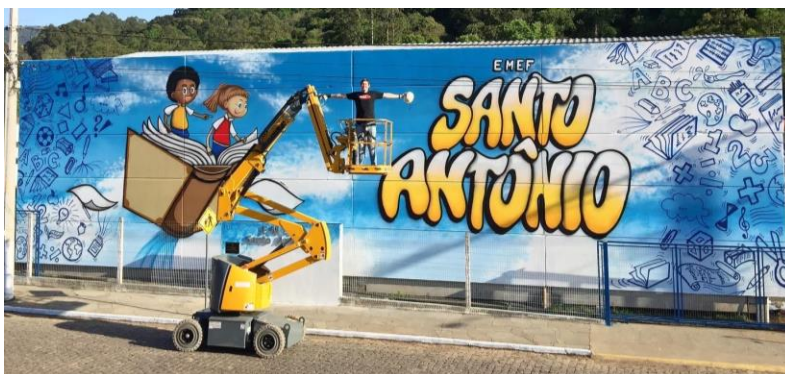
Fachada de escola municipal em Relvado
